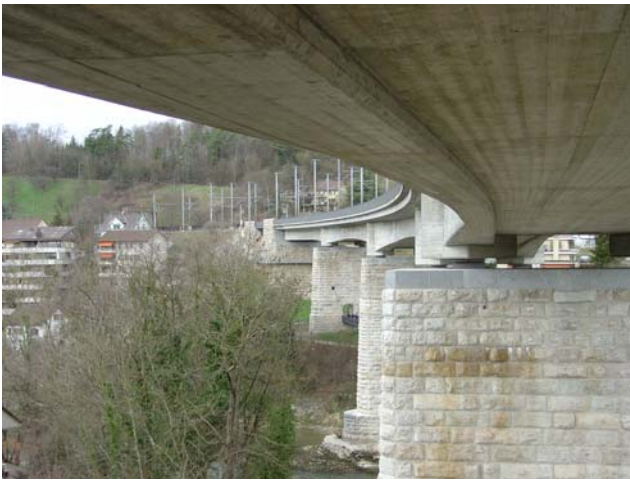
Der Innenbogen Richtung Umiken. Gut sichtbar der erneuerte „Kragens“ der ursprünglichen Pfeiler.
