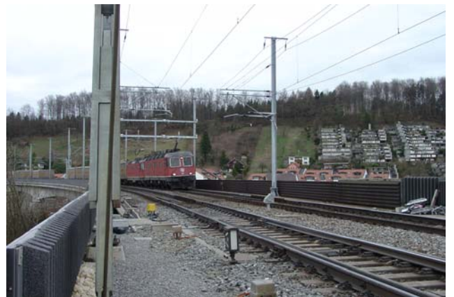
Schwerer Güterzug aus Richtung Umiken. Am Geleise werden gerade Erneuerungen ausgeführt.
